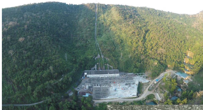
バルーチャン第二発電所全景
