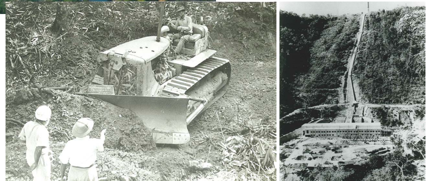
バルーチャン第二発電所の工事風景
