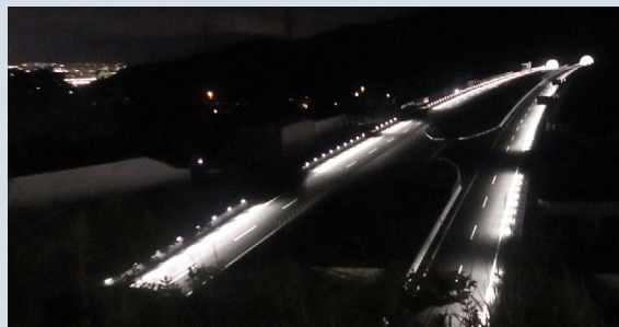
完成した新東名高速道路
