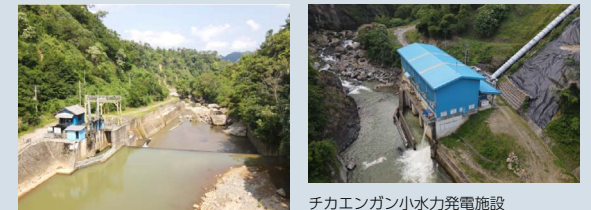
チカエンガン小水力発電施設
