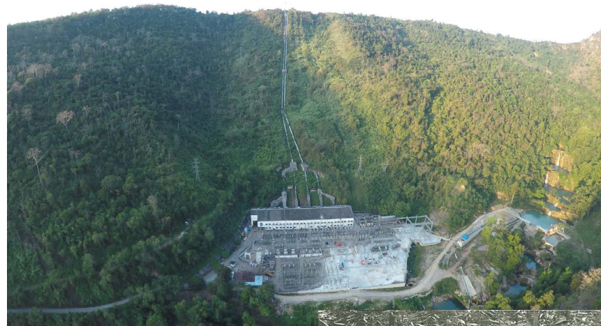
バルーチャン第二発電所全景
