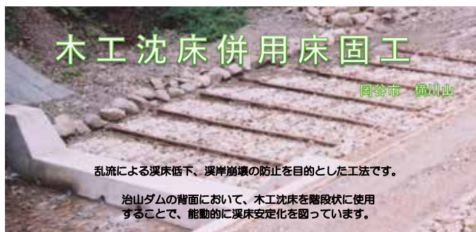
豪雨直後の状況(施工から2年後)① 流出した土砂が堆積しているが、木工沈床の各段が調節機能を発揮している。 豪雨直後の状況(施工から2年後)② 施工から4年後の状況 土砂の堆積・流送を繰り返して、渓床を安定化させながら、自然流路のような状態になっている。
