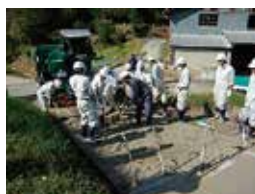
コンクリート打設
