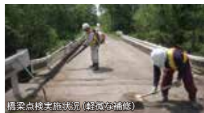
橋梁点検実施状況(軽微な補修)
