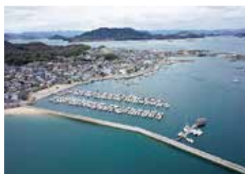
PB係留施設整備後(港内)
