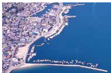
PB係留施設整備前(港内)
