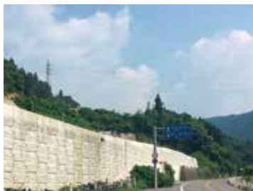
熊本テールアルメ施工実績現場
