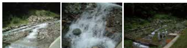
豪雨直後の状況(施工から2年後)① 流出した土砂が堆積しているが、木工沈床の各段が調節機能を発揮している。 豪雨直後の状況(施工から2年後)② 施工から4年後の状況 土砂の堆積・流送を繰り返して、渓床を安定化させながら、自然流路のような状態になっている。
