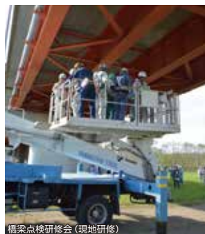
橋梁点検研修会(現地研修)
