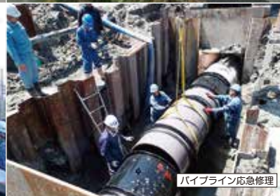
パイプライン破損事故
