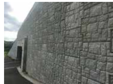
鹿児島テールアルメ施工実績現場
