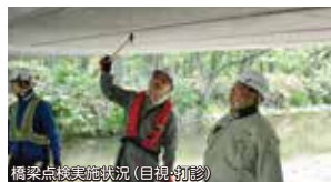
橋梁点検実施状況(目視・切彫)
