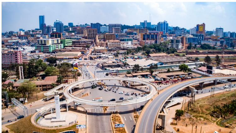
クロックタワー交差点上の高架橋と歩道橋
