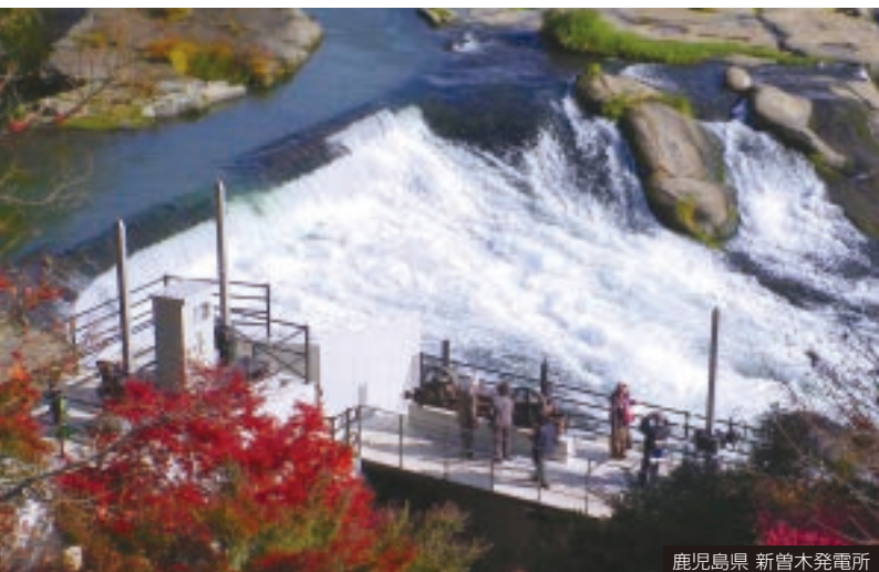
鹿児島県 新首木発電所
