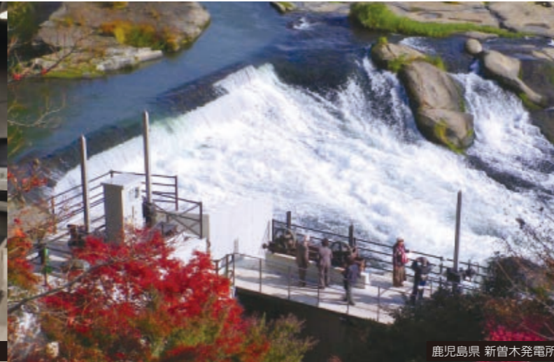
鹿児島県 新曽木発電所
