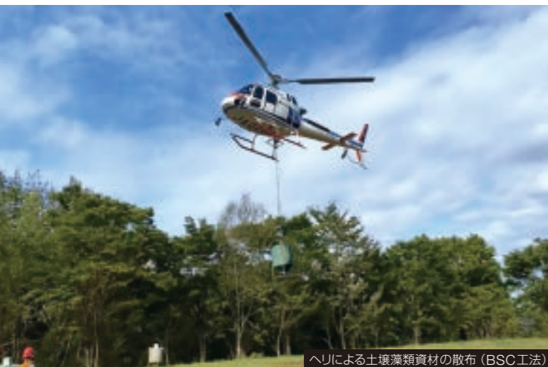
ヘリによる土壌藻類資材の散布 (BSC工法)
