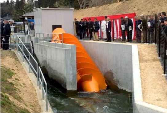
同社が自社開発・製造した、国産初のらせん水車。八幡沢発電所（岩手県一関市）で 2019 年4月に運転開始。らせん水車は低落差で発電でき、枯葉などのゴミが詰まりにくい特長があるため、農業用水路を活用した小水力発電に適している。発電電力は全て東北電力（東証1部、9506）に売電し、建設コスト回収後は農業水利施設の維持管理に充て、農業者の負担の軽減を図る仕組み。
