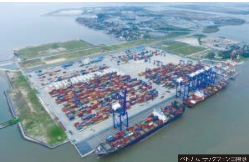
ベトナム ラックフェン国際港
