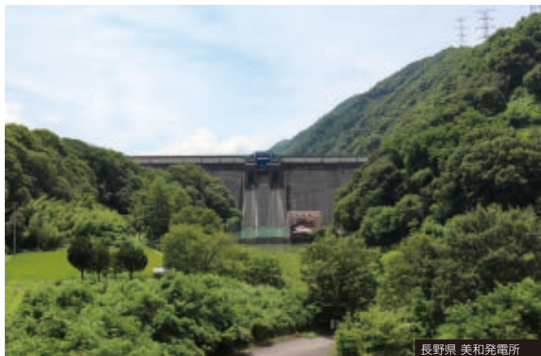
長野県 美和発電所
